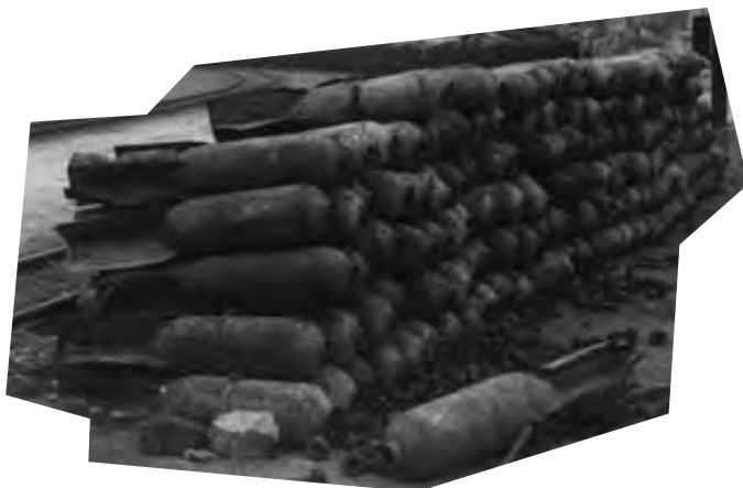
1946 un año después de finalizar La II Guerra Mundial y comprobar que no pasaba nada en el plano internacional, la fábrica decide retirar las bombas de la guerra civil y apilarlas como “chatarra”.
