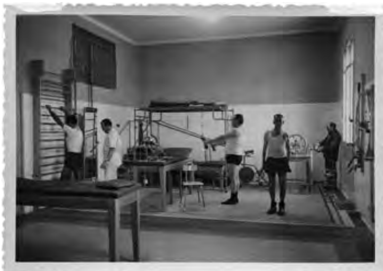
Sanatorio de AHV. Sala de rehabilitación. Manuel Rodríguez Velo. 22 de febrero, 1963. 8x12 cm. Gelatina de plata. Fundació de la C.V. de Patrimoni Industrial de Sagunt.
