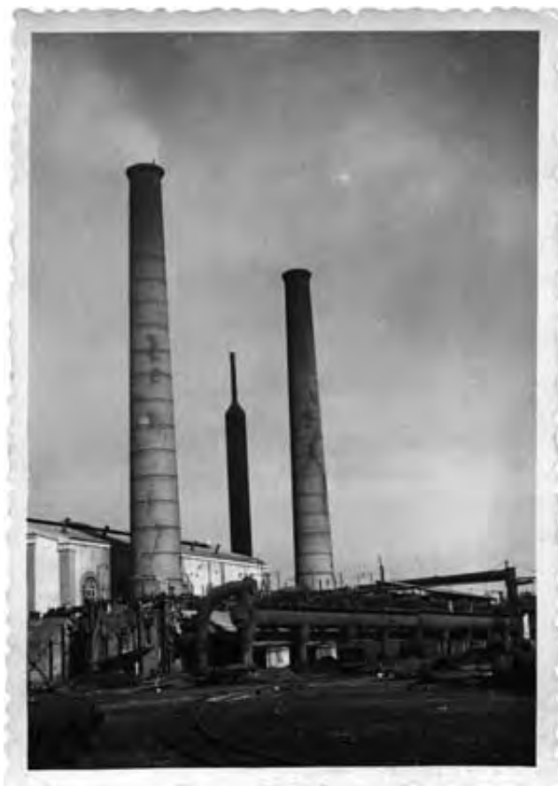
Central de fuerza. Chimeneas.
