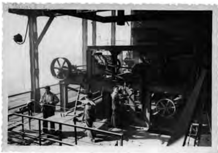
Instalación de una máquina de sintering. Manuel Rodríguez Velo. 13 de junio, 1950. 8x12 cm. Gelatina de plata. Fundació de la C.V. de Patrimoni Industrial de Sagunt.
