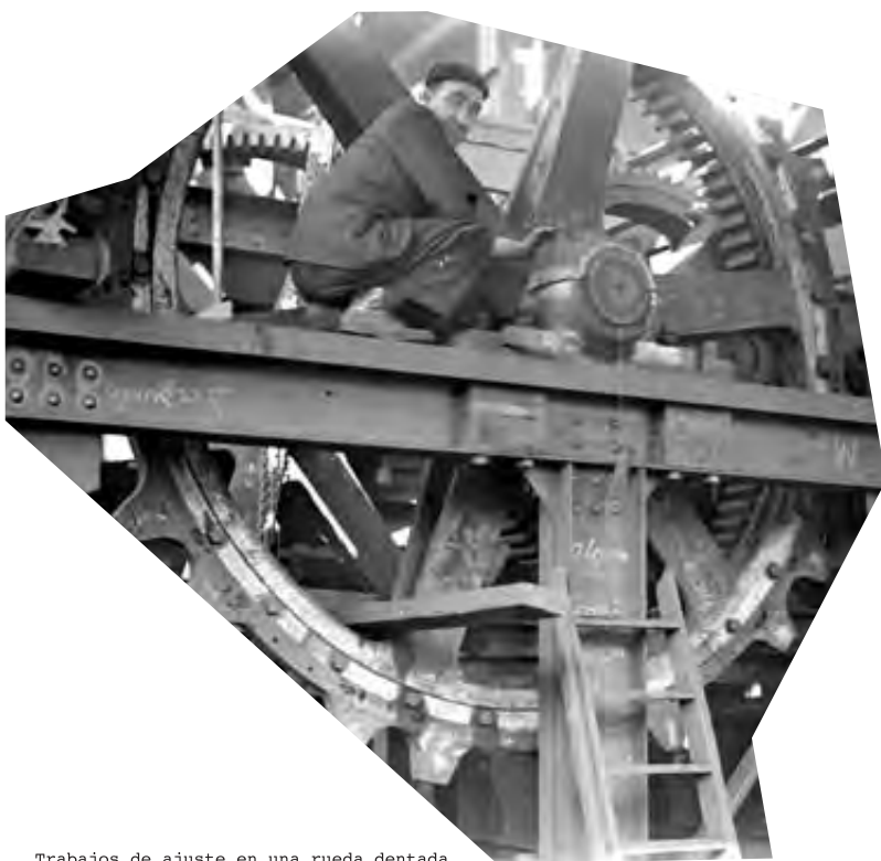
Trabajos de ajuste en una rueda dentada.
