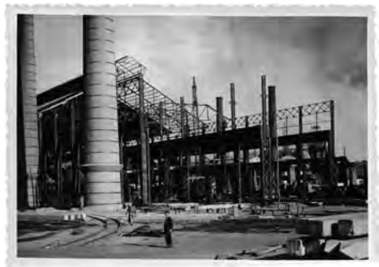
Ampliación de los hornos de acero. Entramado metálico de los hornos 7 y 8.
