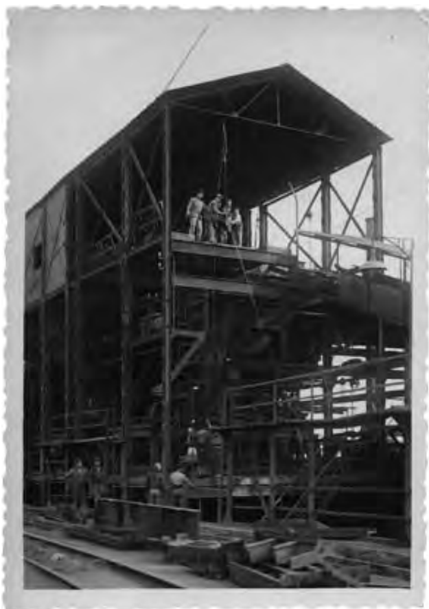
Instalación de una máquina de sintering. Manuel Rodríguez Velo. 27 de junio, 1950. 8x12 cm. Gelatina de plata. Fundació de la C.V. de Patrimoni Industrial de Sagunt.
