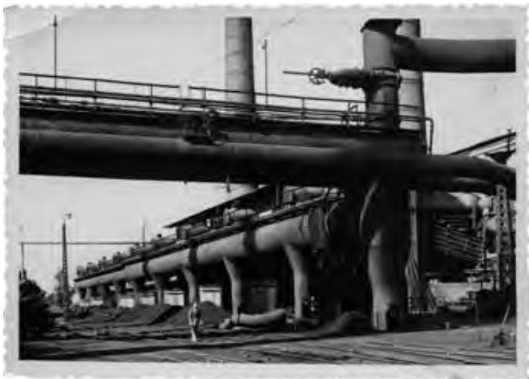
Horno alto. Tubería principal de gas. Manuel Rodríguez Velo. 27 de julio, 1949. 8x12 cm. Gelatina de plata. Fundació de la C.V. de Patrimoni Industrial de Sagunt.
