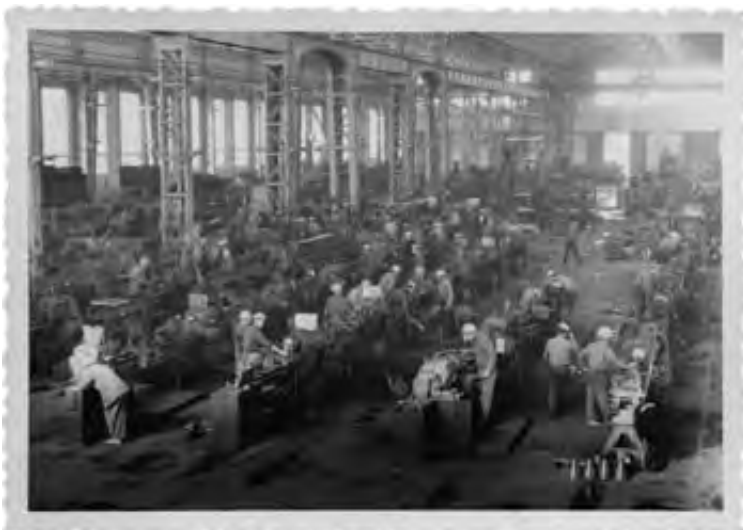
Obreros en la Nave de talleres.
