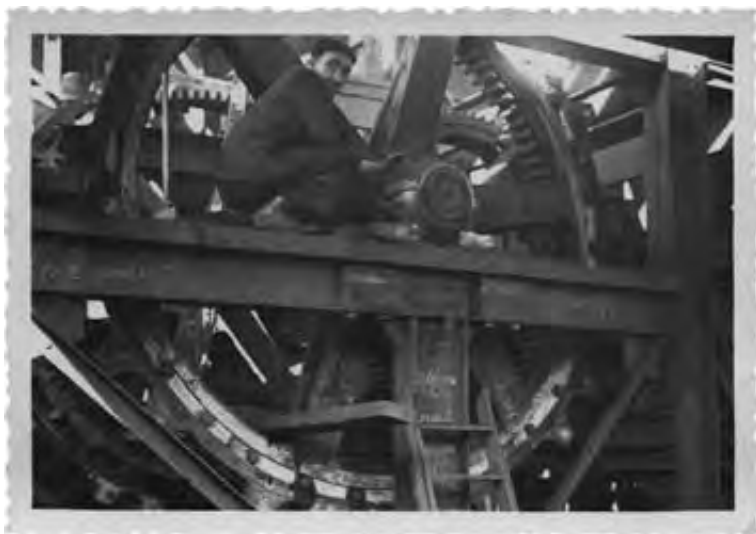
Trabajos de ajuste en una rueda dentada. Manuel Rodríguez Velo. 19 de noviembre, 1947. 9,5x13 cm. Gelatina de plata. Fundació de la C.V. de Patrimoni Industrial de Sagunt.
