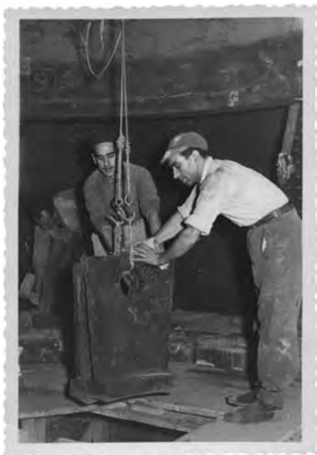
Interior horno alto nº 3. Colocación de placas.
