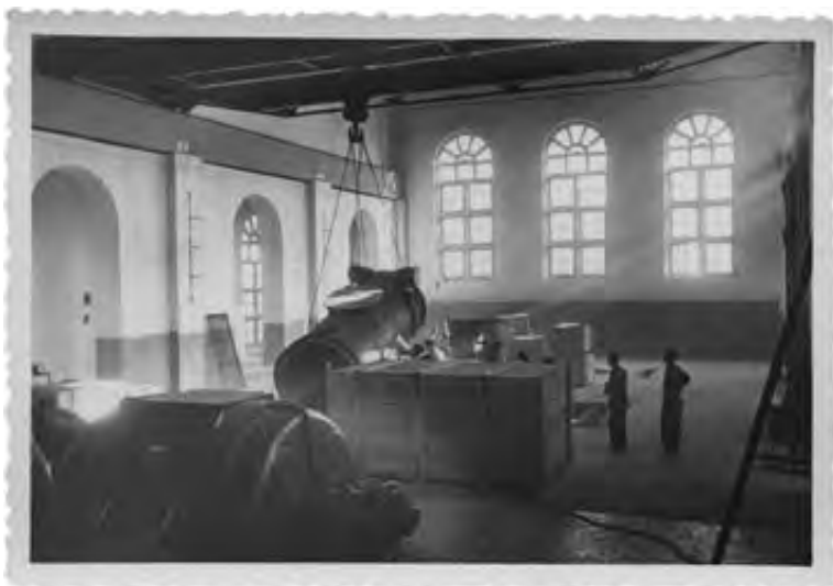
Ampliación de la Central de fuerza. Interior. Manuel Rodríguez Velo. 27 de abril, 1954. 12x8 cm. Gelatina de plata. Fundació de la C.V. de Patrimoni Industrial de Sagunt.
