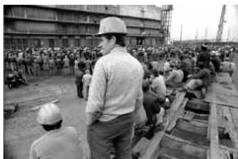
Assemblea de treballadors a l'interior de la fàbrica. Foto: Jesús Císcar.
