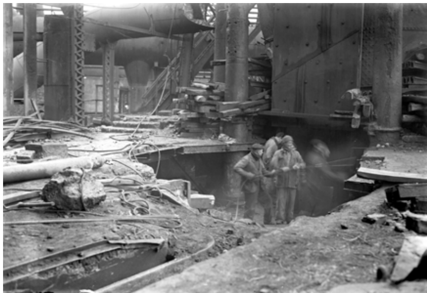
Imatge 2. Reparació de l'alt forn núm. 2. Foto: Manuel Rodríguez Velo, 1949. Fundació de la Comunitat Valenciana de Patrimoni Industrial i Memòria Obrera del Port de Sagunt.
